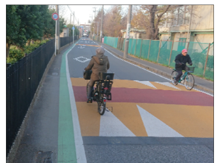
ハンブ設置状況
