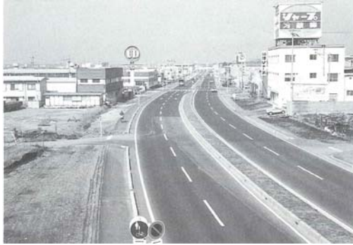
完成直後の状況(昭和 48 年) 出典；国土交通省沼津河川国道事務所
