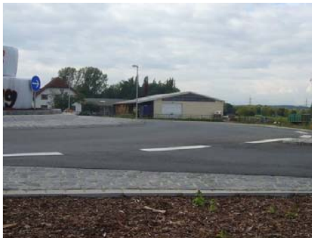
(c)段差のある敷石のエプロン (Groß-Zimmern)
