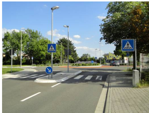
図 3.6 標準ラウンドアバウト流出入部における二段階横断の例(ドイツ・Kelsterbach)
