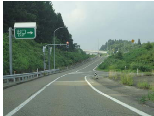
図2.2 自動車専用道路インターチェンジ内のランプ間交差部における信号制
